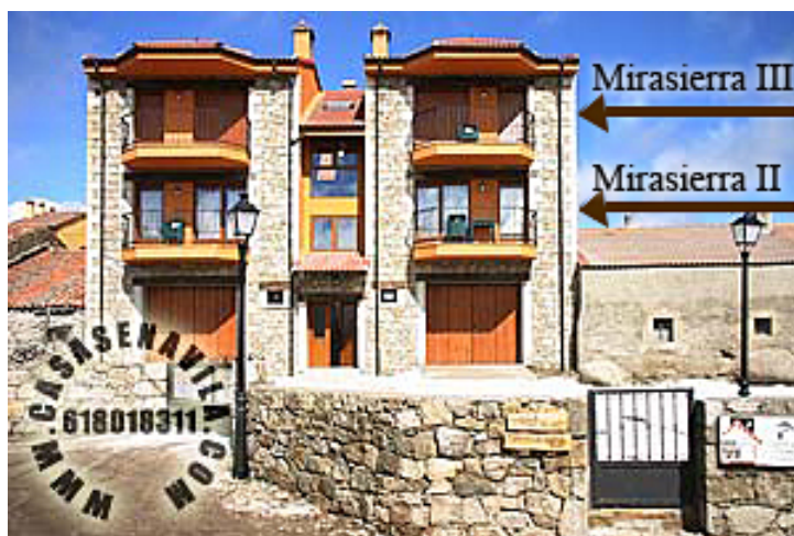
Fachada (Cada Casa en 1 Planta)
